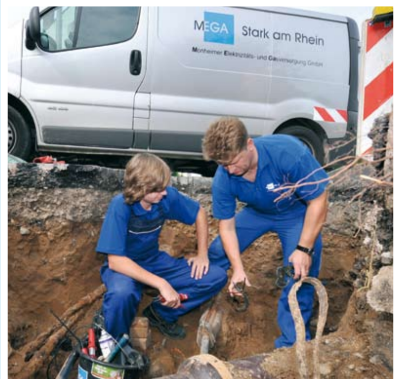
MEGA-Auszubildender Marcel Brodkorb und Elektro-Monteur Martin Labisch bei der Reparatur einer Erdleitung auf der Monheimer-Straße.
